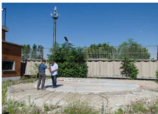
Foto 14 – Area circolare su cui era presente una cisterna di olio pesante utilizzato come carburante per le caldaie dell’adiacente Centrale Termica, a sinistra della foto.
