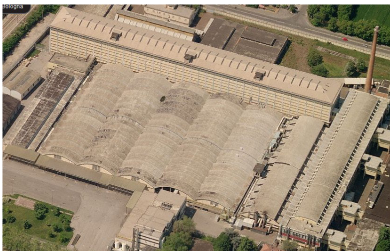
Img. 2.7.28 - Vista della copertura
