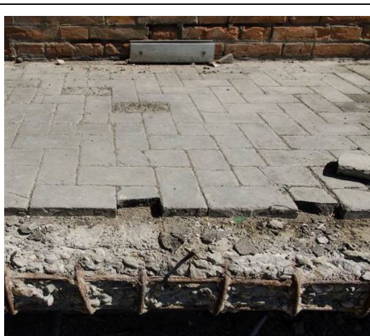
Foto 22 – Particolare della pavimentazione in mattonelle di asfalto, tipica dei fabbricati tecnici (officine, depositi, capannoni).
