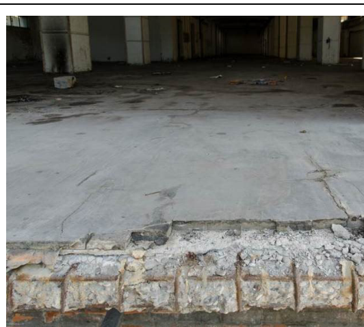
Foto 23 – Particolare della pavimentazione interna del fabbricato Deposito sale sofisticato (24a); le mattonelle di asfalto sono rivestite superficialmente da uno strato di resina protettiva.
